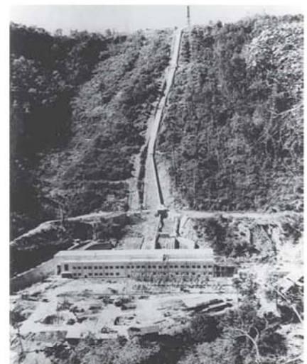
バルーチャン第2水力発電所 (出力84MW、1960年完成)
