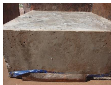
Finish of GE-RCC (Method 2)
