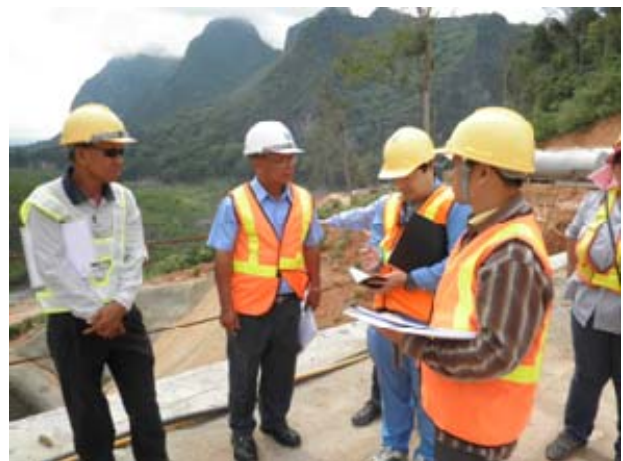
Fig. 4 A project site
