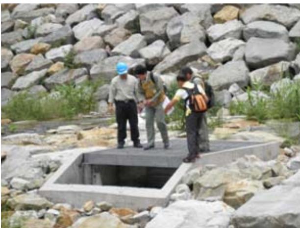
Fig. 6 B project site
