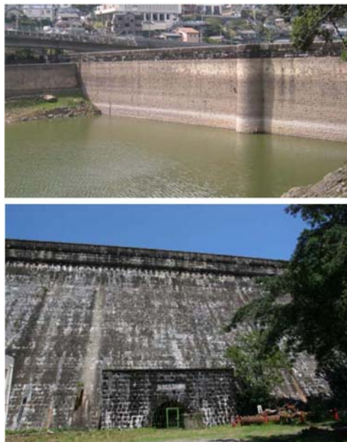
Photo 3 Upstream and Downstream Surface of the Hongouchi-teibu Dam Surfaces en amont et en aval du Barrage de Hongouchi-Teibu (Partie basse)
