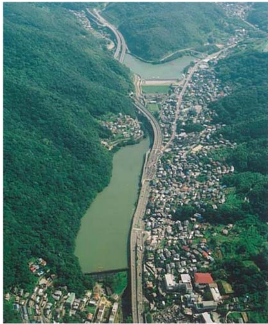
Photo 2 Hongouchi-kobu and -teibu Dam Barrages de Hongouchi-Kobu (Partie haute) et de Hongouchi-Teibu (Partie basse)
