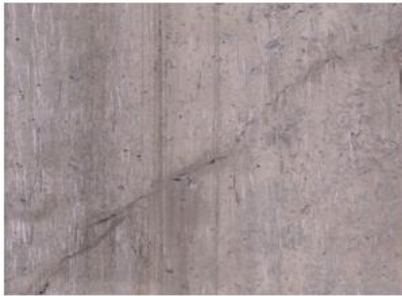
Fig. 9 Example of a crack shown in recorded image Exemple d'une fissure trouvée dans l'image enregistrée
