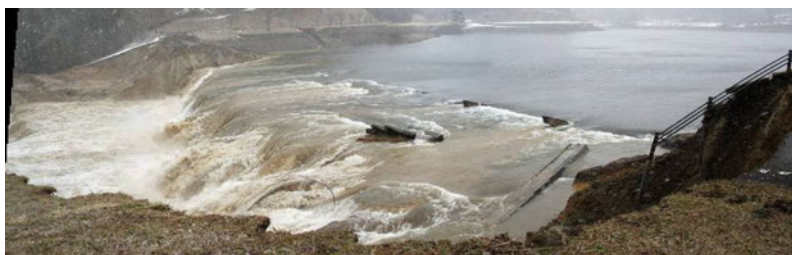
Fig. 1 Failing main embankment of the Fujinuma Dam (ataround 15:11, 11th March 2011) Digue principale défailante du Barrage de Fujinuma (vers 15 h 11, le 11 mars 2011)
