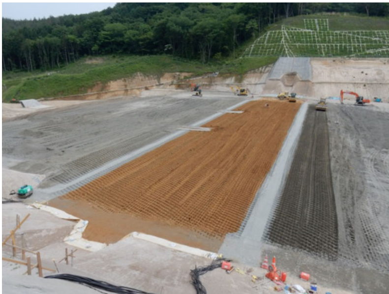
Fig. 6 Embankment work Travaux d'endiguement
