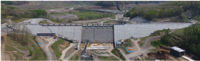
Fig. 1 Apporo dam under construction Barrage d'Apporo en construction
