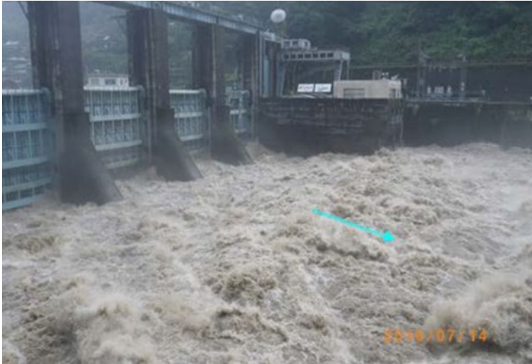
Fig. 7 Photo of sediment sluicing in Setoishi Dam Photo de sluice sédiments dans Setoishi Dam
