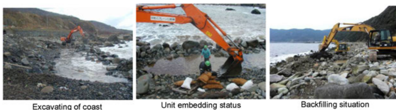
Fig. 13 Excavating of coast and embedding of unit Excavation de la côte et encastrement de l'unité
