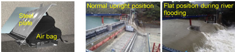
Fig. 15 Overview of operation using temporary gate Aperçu de l'opération avec la barrière provisoire
