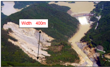
Fig.3 Slope failure downstream of the Tsukabaru dam Éboulement du versant en aval du barrage de Tsukabaru
