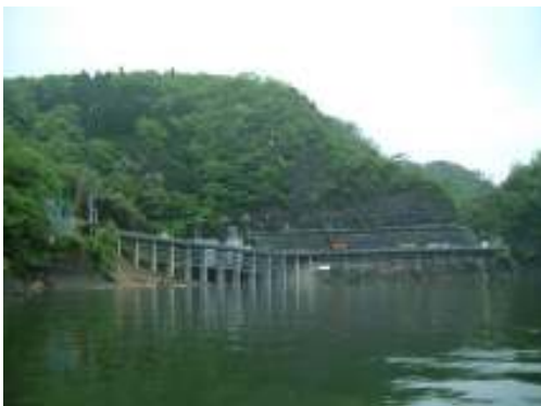
Fig. 9 Steel-made temporary road in the reservoir Route temporaire en acier dans le réservoir
