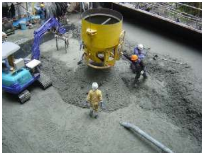
Fig.13 Concrete placing Déposition du béton
