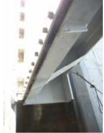
Status of Bypass Main Gate (On August 20, one month after discharge) Porte principale de la dérivation (le 20 août environ un mois après le flux)
