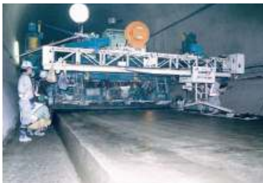
Photo 8 Construction by Slipform La méthode de bétonnage "coffrage glissant"
