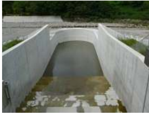
Status of Mibu River Bypass Tunnel Outlet (On August 17, one month after discharge) Sortie de la dérivation de la rivière Mibu (le 17 août environ un mois après le flux)
