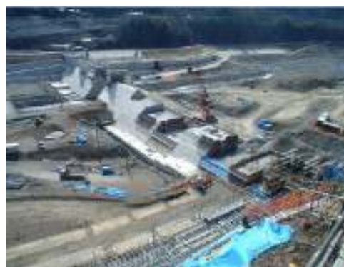
Photo 9 Construction of Concrete Diversion Weir Seuil de dérivation en béton en cours de construction
