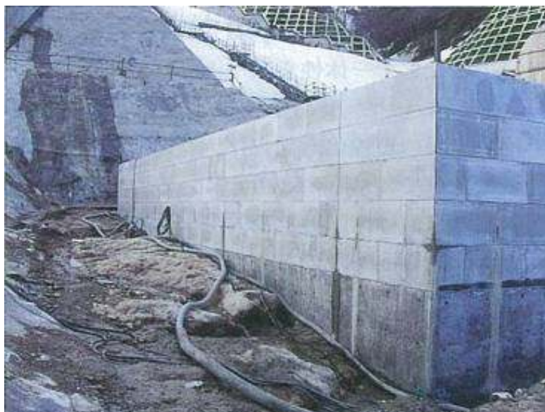
Fig. 13 Installing footing formwork (outside) Coffrage d'une semelle (vue extérieure)
