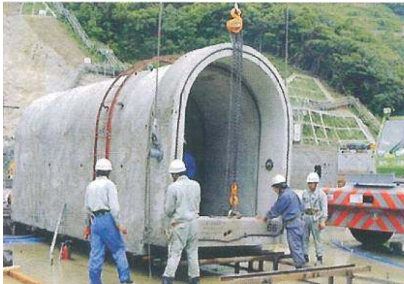
Fig. 2 Installing a precast segment of gallery Mise en place d'un élément de galerie préfabriqué
