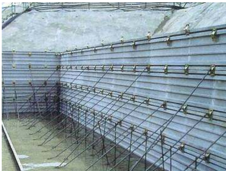
Fig. 12 Installing footing formwork (inside) Coffrage d'une semelle (vue intérieure)
