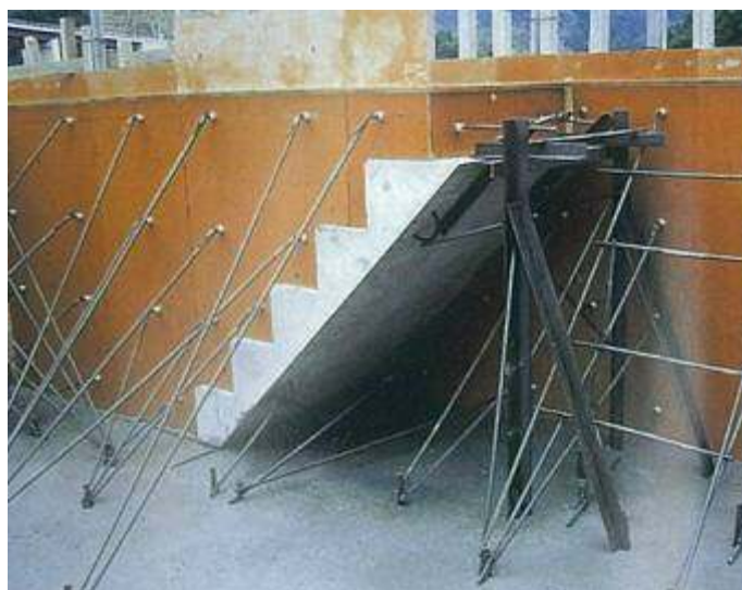
Fig. 16 Precast formwork for footing staircase Coffrage préfabriqué pour escalier
