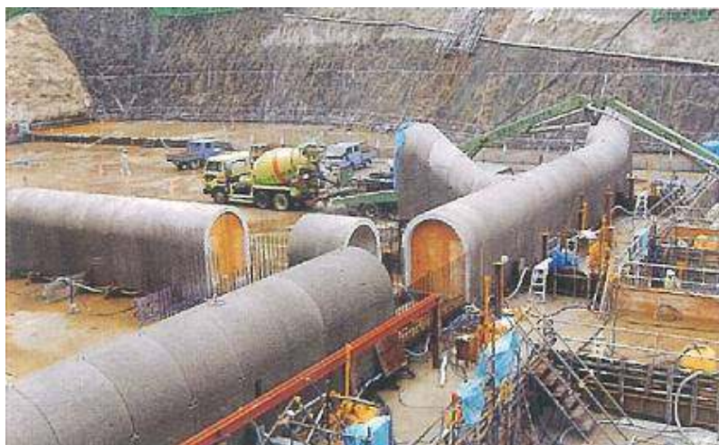
Fig. 3 Positioning precast galleries Positionnement de galeries préfabriquées
